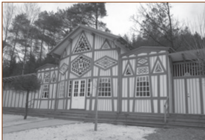
Snímek centrální části - rekonstrukce proběhla v roce 2019.
