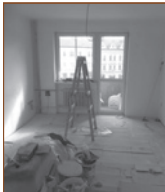
PRŮBĚH rekonstrukce - byt č. 4
