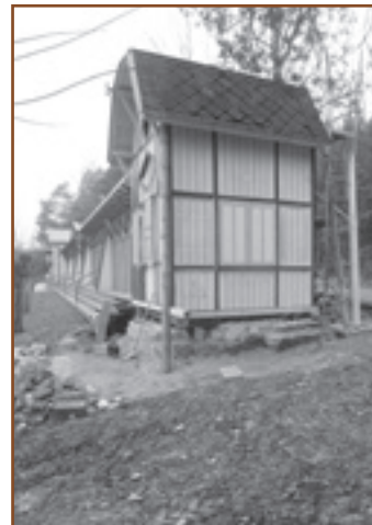
Fotografie východního pavilonu - pokladny. Rekonstrukce probíhá nyní.
